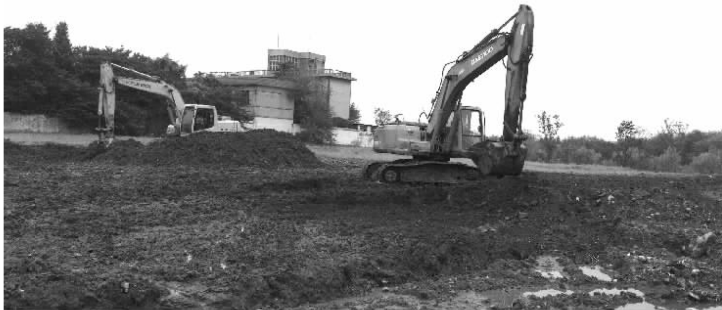
挖掘机正在平整用于开工典礼的大型会场
