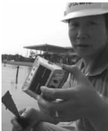
工人正在沿湖岸安装警示灯
