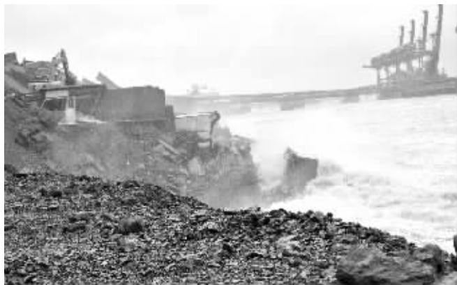
防波堤垮塌现场(8月8日摄) 新华社记者 闫平 摄
