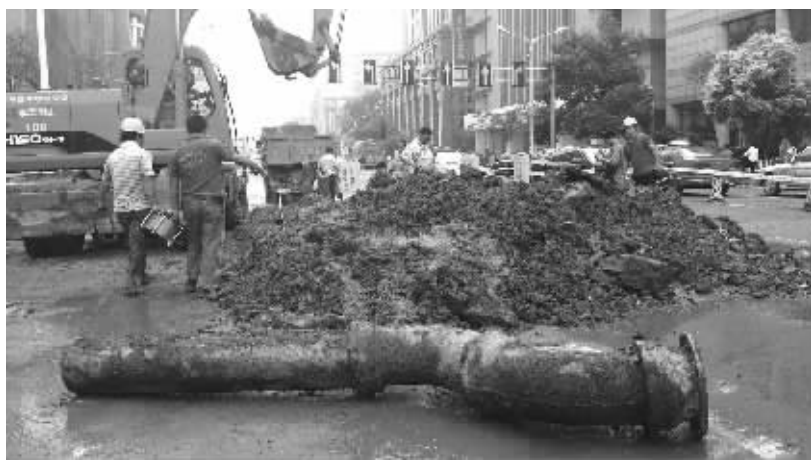
抢修人员正在现场抢修
