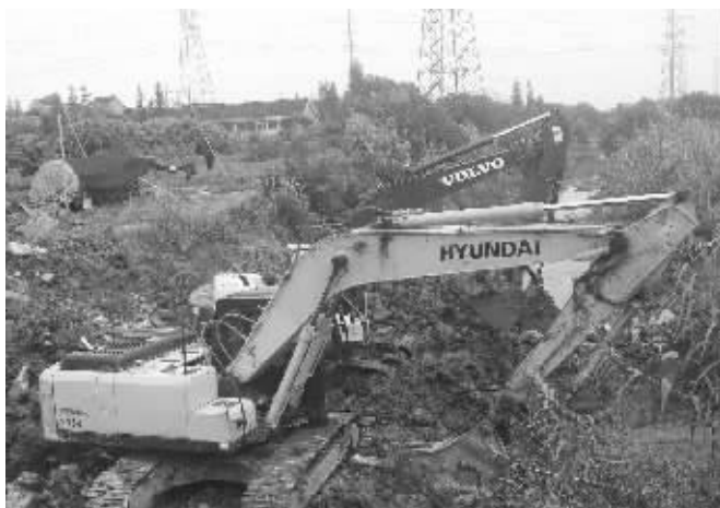
才用了一年多的水泥桥被拆成一堆废墟
