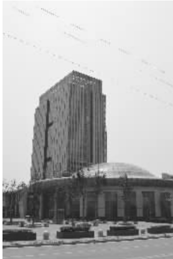
投巨资建成的新汽车西站,如今却迟迟未能启用,成为无锡奇怪的一景
