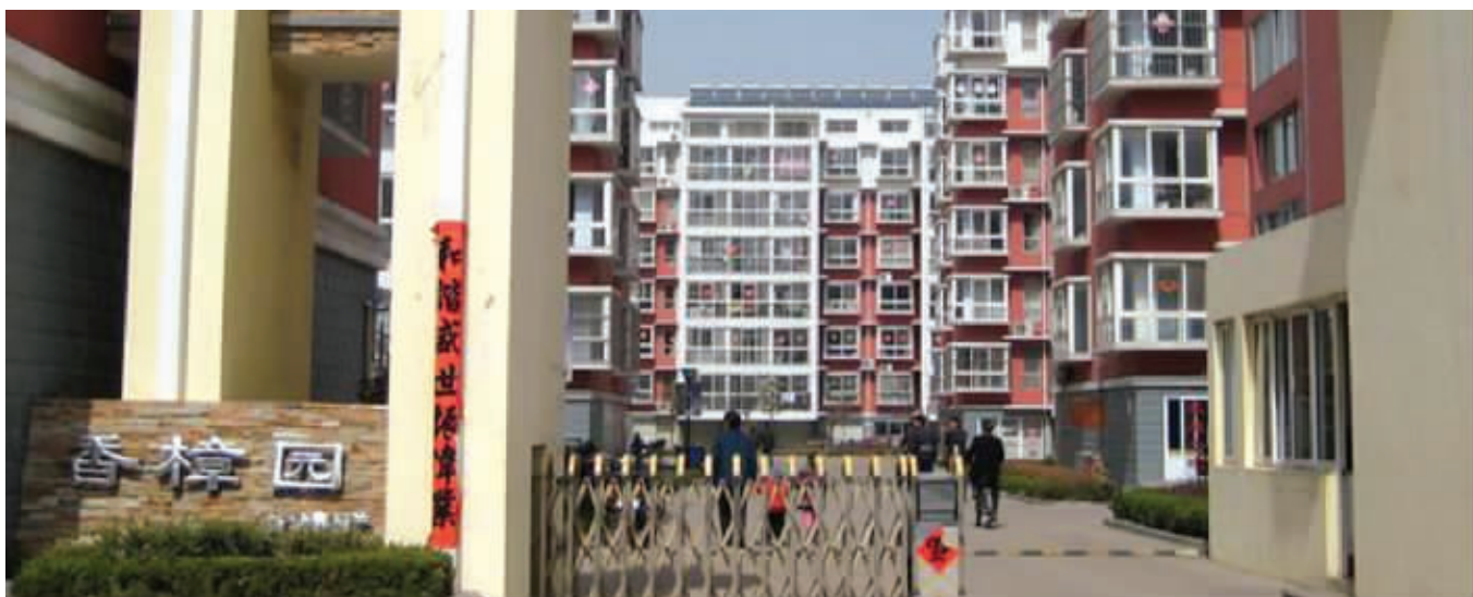
香樟园小区早已交付,但施工方却称1500万元工程款没拿到 资料图片
