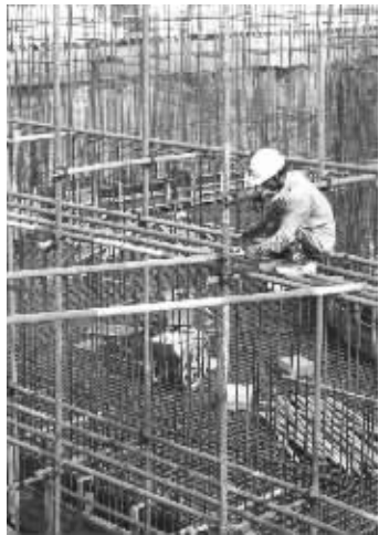
建筑工人顶着太阳施工 王怡径然 摄
