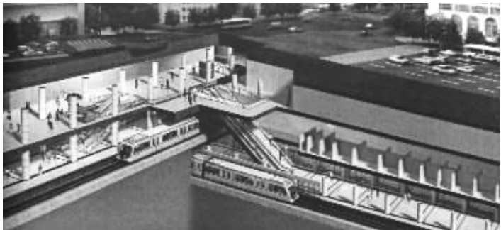
3号线在负二层,4号线在负三层,两线车站站台宽度为13米 资料图片
