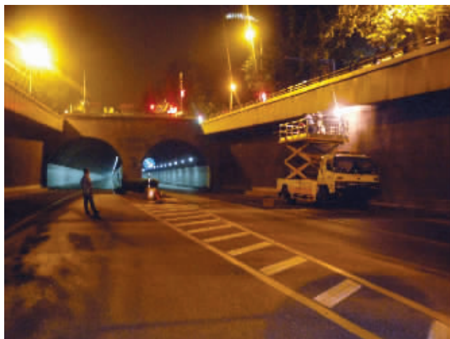
鼓楼隧道封闭期间,工作人员检修路灯 快报记者 李绍富 摄
