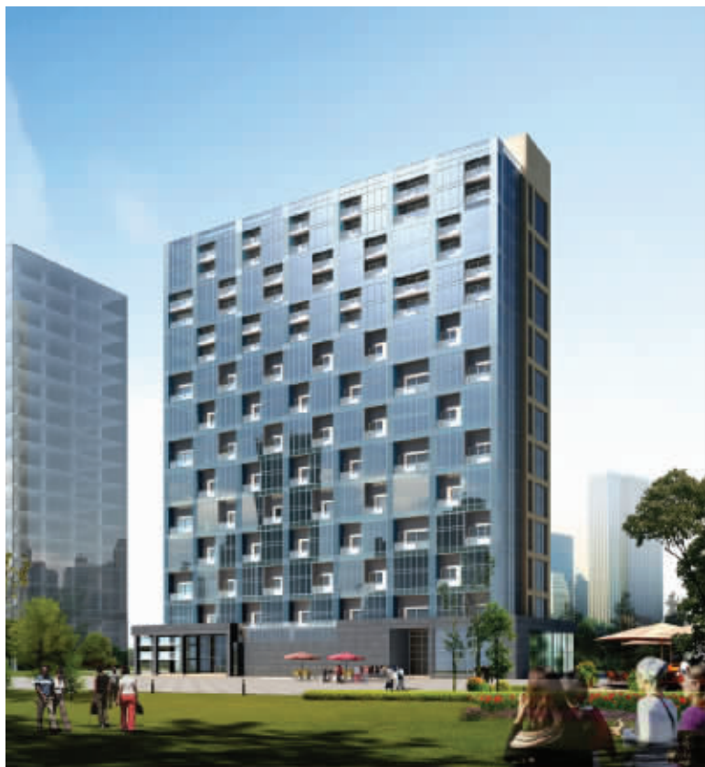
过道自然采光,既确保整体结构新颖,又减少公摊电费
