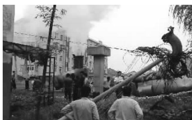
昨日12点05分，横山大桥附近的蒸汽管道波纹管突然发生爆管，气浪喷射高达30多米。幸好爆管位于无人区，没有造成人员伤亡。
