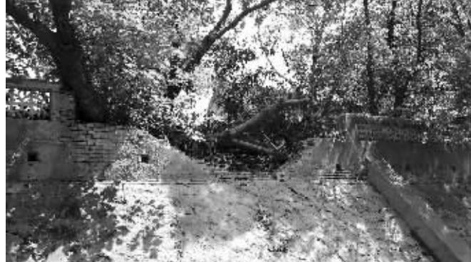
，很多树都长到了30多厘米粗，完全倾倒在围墙上了。加上当时建造这堵围墙时基础就不是很牢固，经过风吹日晒，围墙根本经不住树的压力。“这次真是万幸，大树压垮围墙的时候没有砸到人和车，但是其他几处已经被大树压歪、开裂的围墙会不会出问题，谁又说得准呢？”回想起当时的情
