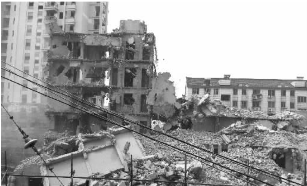
正在拆除中的楼房 快报记者 匡笠 摄
