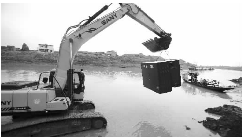
高淳旱情解除,水碧桥翻水点拆除曾经“汲水”救湖的泵阵 快报记者 路军 摄
