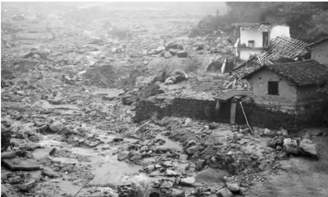
6月10日,受暴雨袭击的岳阳临湘市詹桥镇观山村到处都是倒塌的房屋与滚落的巨石
