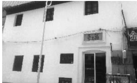
经过维修的小楼“补庐”
