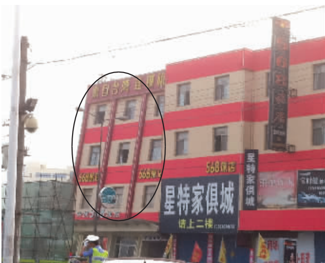
图中画圈部分明显发生倾斜
