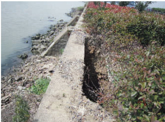
太湖护岸的大坑约有12立方米,成人可以很方便地穿过 沈顾佳 摄
