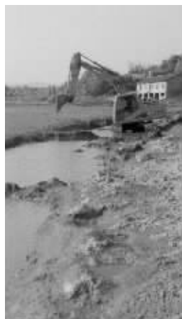
挖掘机试图从湖底挖出水来
