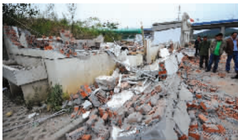
发生事故的现场
