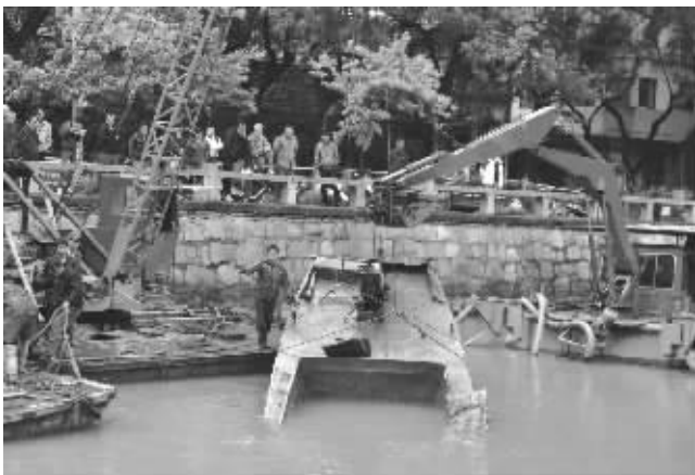
经过两个多小时的打捞,清淤船终于浮出水面
