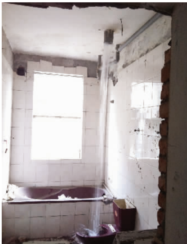
二楼马桶放出的水从一楼天花板上的排粪管管桩喷射而出
