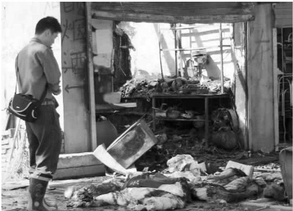
消防人员在检查起火原因 实习生 朱辰辰 摄
