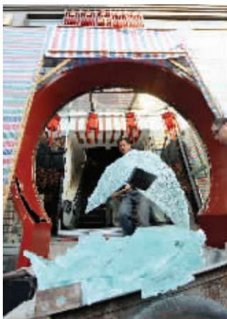
“霸道”玻璃房开拆 快报记者赵杰摄
