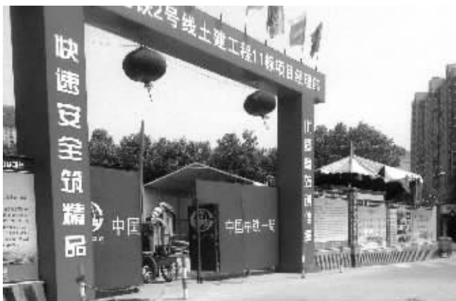
昨天无锡地铁2号线建设工地上时有工人进出 快报记者 陆媛 摄
