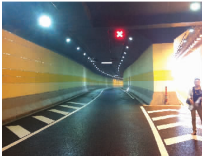
隧道里的运河东路入口匝道
