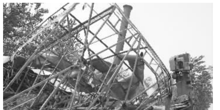
被大风吹翻的广告牌和吊车 快报记者 李绍富 摄
