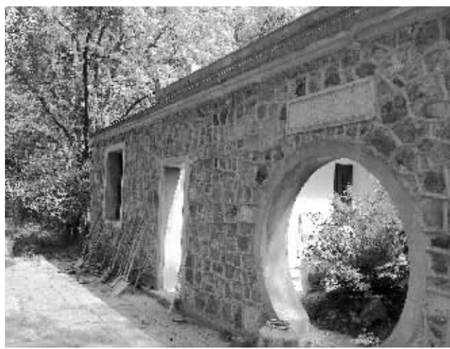
永慕庐牌匾下摆放着铁锹和塑料桶
