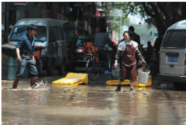
据了解，南昌路最近才结束雨污分流工程，位于南汽宾馆门前的道路尚未铺好沥青路面，挖出的沟渠由碎石子填充。昨天上午11点半左右，在这里开花店的潘小姐发现，碎石子铺过的路面中间突然喷出一股泥水，强大的水压将路面顶出一个直径约四十多厘米的豁口，自来水喷出1米多高。“水势很大，几分钟的工夫就漫到路对面去了。”
