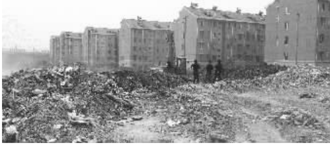
正在建设的停车场紧挨着居民楼
