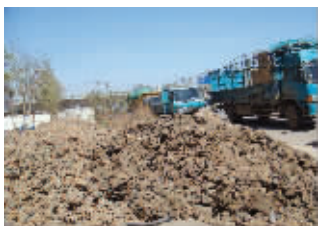
南京南站工地附近路旁的渣土 快报记者 安莹 摄
