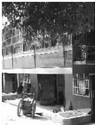
被卖掉的地下室正在施工
