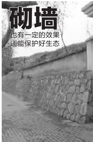
建了挡土墙,东吴路好久没滑坡了
