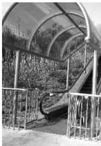
扶梯入口处已用绳子拦了起来
