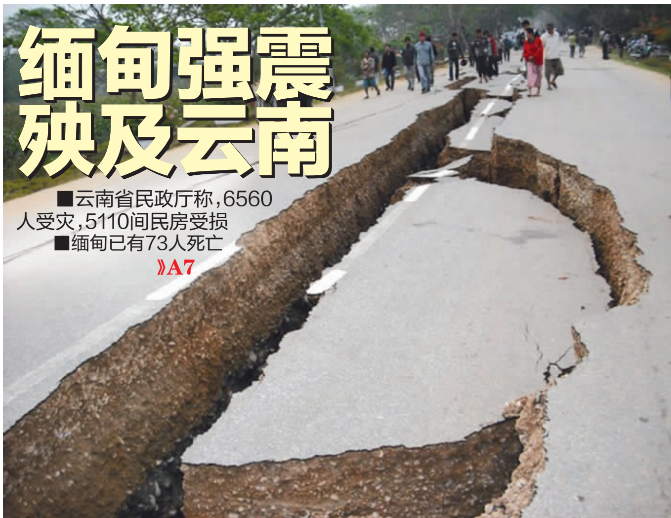
3月25日,人们在缅甸塔莱镇一条被震裂的道路上行走 新华社/路透
