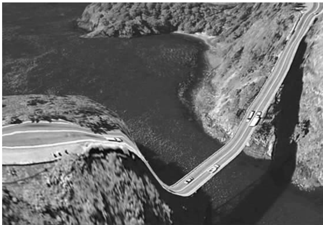
横跨在海湾之上的大桥
