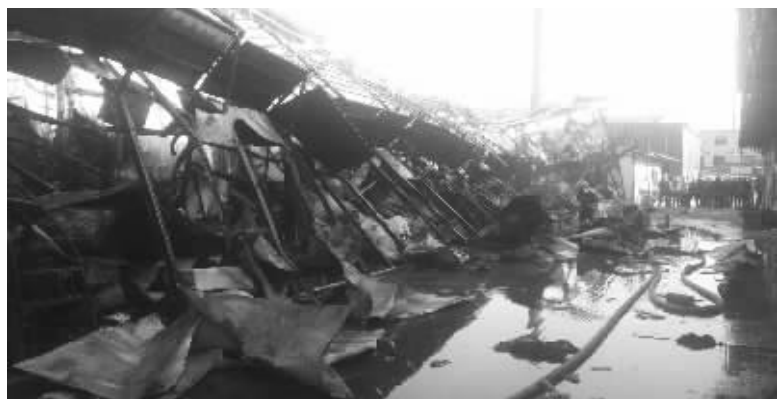
整排的民工宿舍在大火中垮塌 快报记者 李彦 摄
