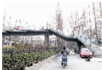
浮桥站附近的过街天桥将拆除
