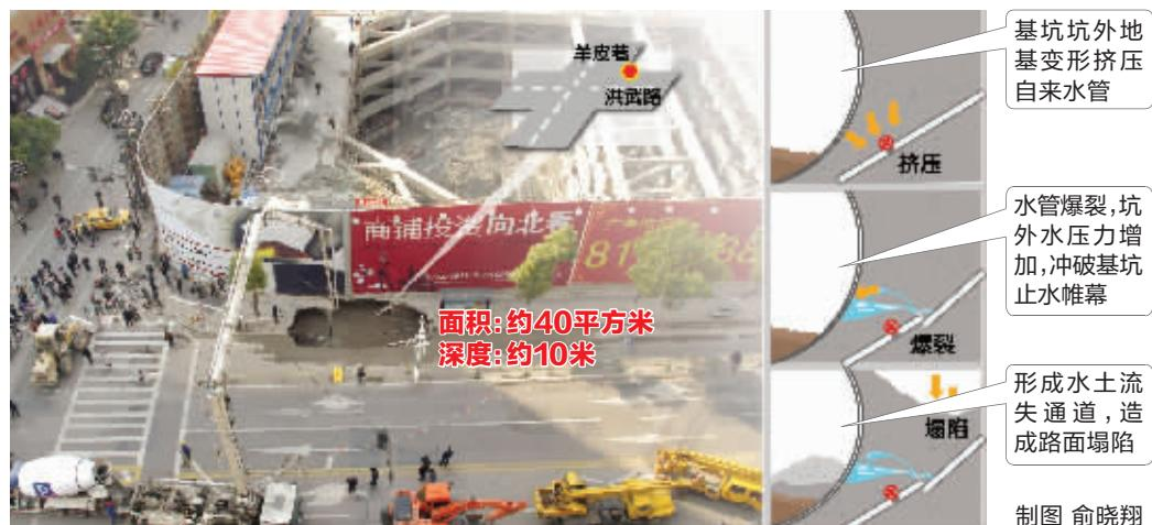
基坑外地基变形挤压自来水管道
