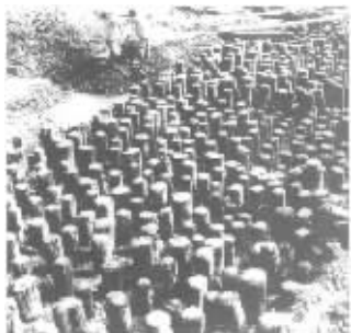
明故宫地下的梅花桩,据说不仅能承重,还有军事防御的作用
