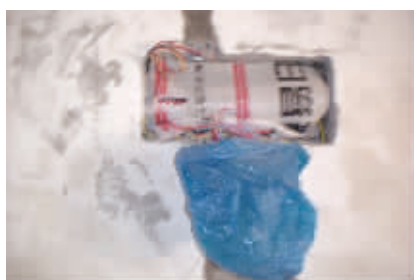
弱电箱裸露着,一大团电线用一个塑料袋子裹着,较易发生火情
