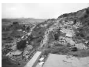
山体滑坡埋了至少400间房屋
