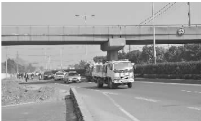
横跨312国道即将被拆除的东升西立交
