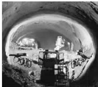
准备进行爆破的坑洞
