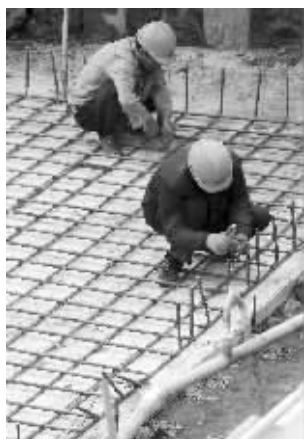
捆扎钢筋的工人
