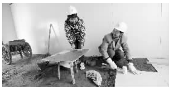
在建设工地上过年的工人 快报记者 赵杰 摄
