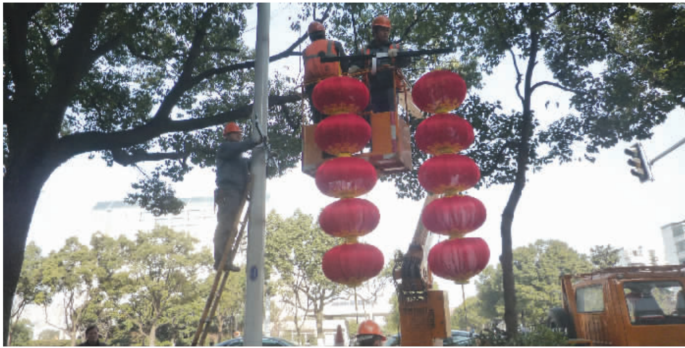
三香路市政府门口,工人正在安装灯笼
