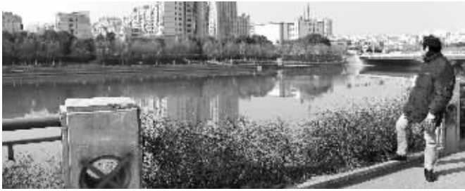
损坏的护栏 快报记者 施向辉 摄
