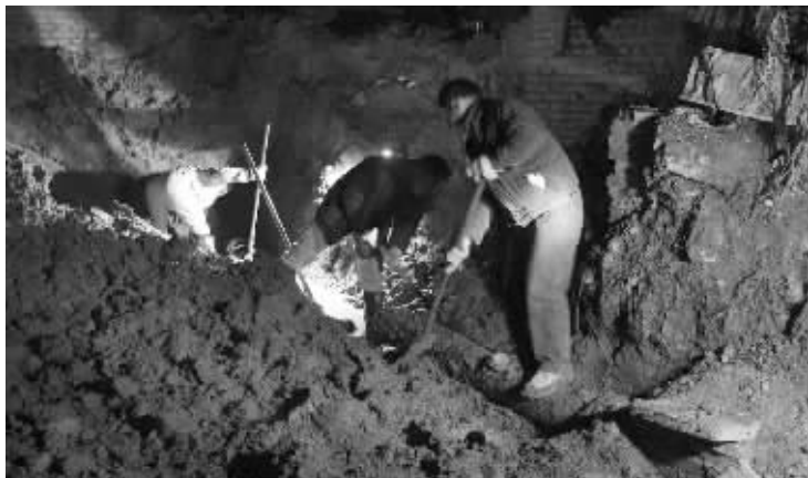
维修人员正在紧急堵漏点 快报记者 辛一 摄
